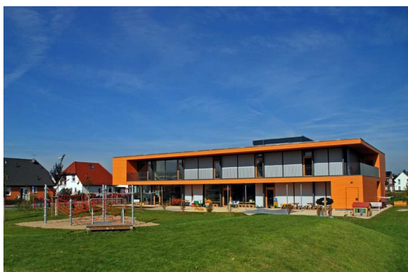
Kita Zauberhaus kurz vor der Inbetriebnahme 08_2013 Foto: C. Maurer/Stadt Delitzsch
