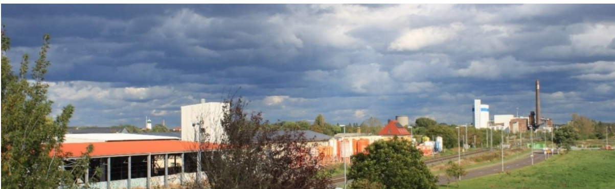
Abbildung 30: Blick aus erhöhter Position von der Brücke der B 184 / Eisenbahnstrecke Halle-Guben – Blickrichtung Ost in ca. 1.150 m Entfernung zum Schornstein). Die Landschaft ist stark technogen überprägt durch Eisenbahn und Gewerbe- und Industriebauten. Vistas auf Türme von Delitzsch sind möglich – sie werden nicht durch die Gebäude des CTC verändert.
