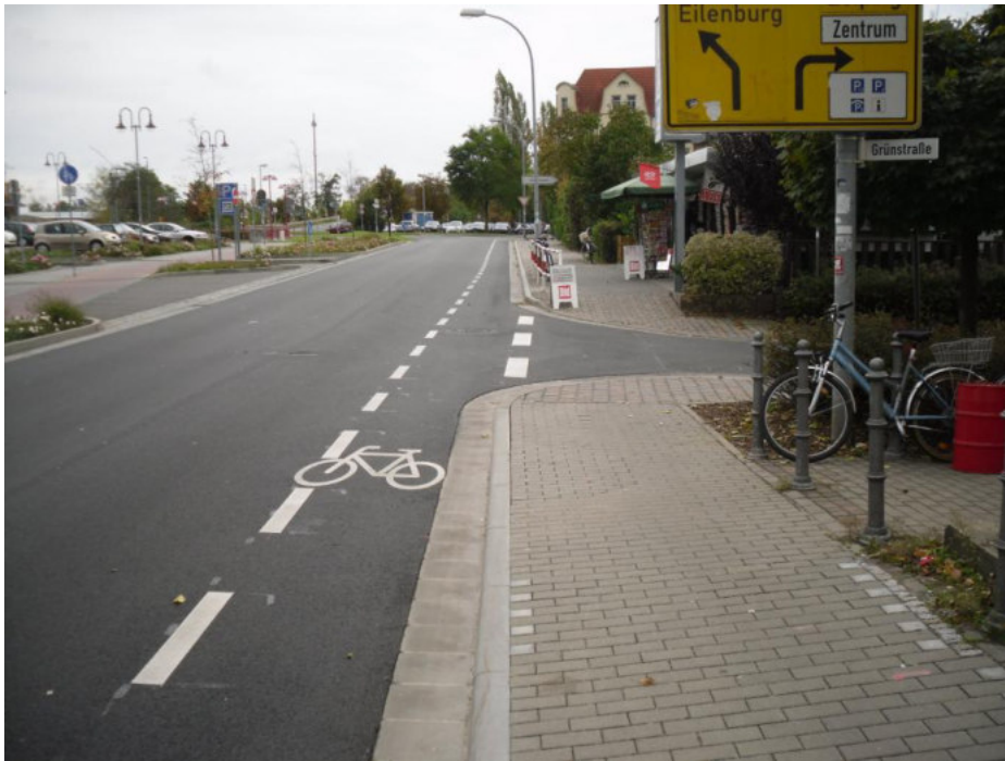
Abb. 27: Regelkonformer Schutzstreifen in der Eisenbahnstraße
