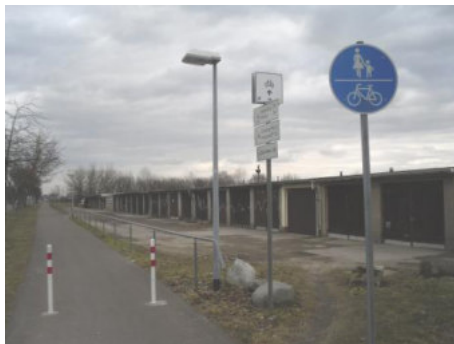
Beerendorfer Straße: gutes Beispiel einer Radverkehrsanlage in Asphaltbauweise
