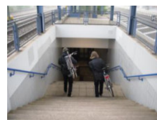
fehlende Schieberampen am Unteren Bhf.
