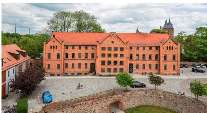
Verwaltungsgebäude II (Technisches Rathaus) der Stadtverwaltung Delitzsch, Foto: Peter Franke.
