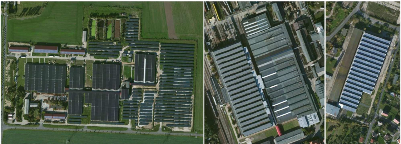
Abbildung 5-2: PV-Dachanlagen Benndorfer Landstraße (links), Karl-Marx-Straße (Mitte) und Im Ziehwerk (rechts)
