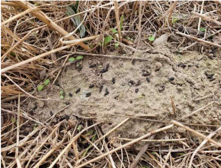
Mäusekot an Baueingang.
