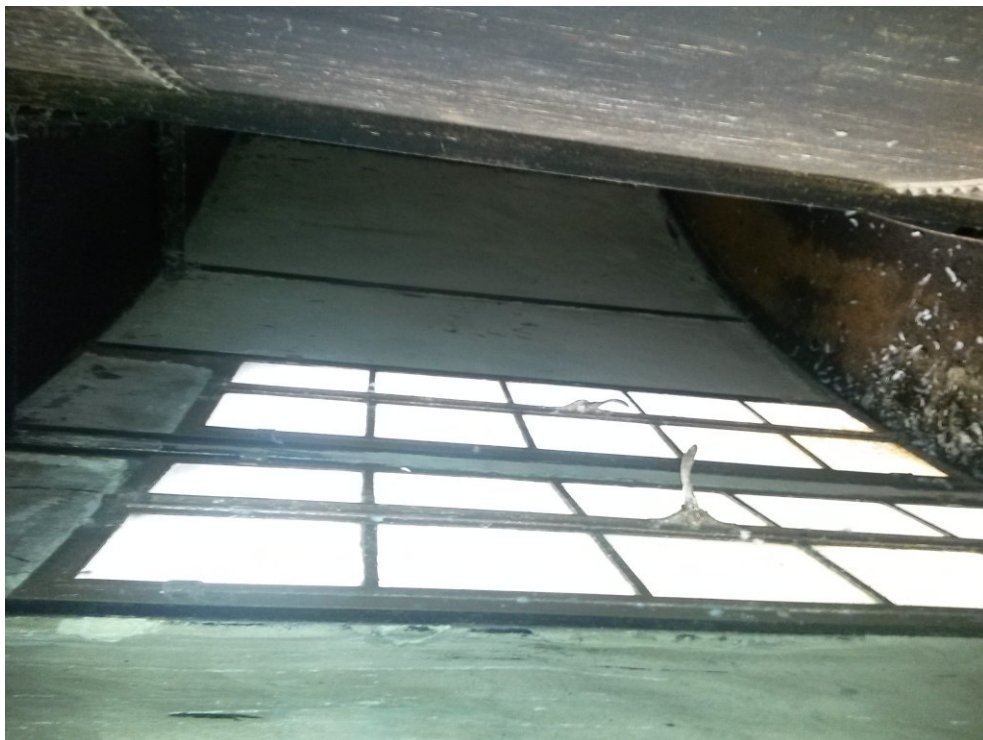
Bild 9 – Kontrolle der Fenster auf Kot
