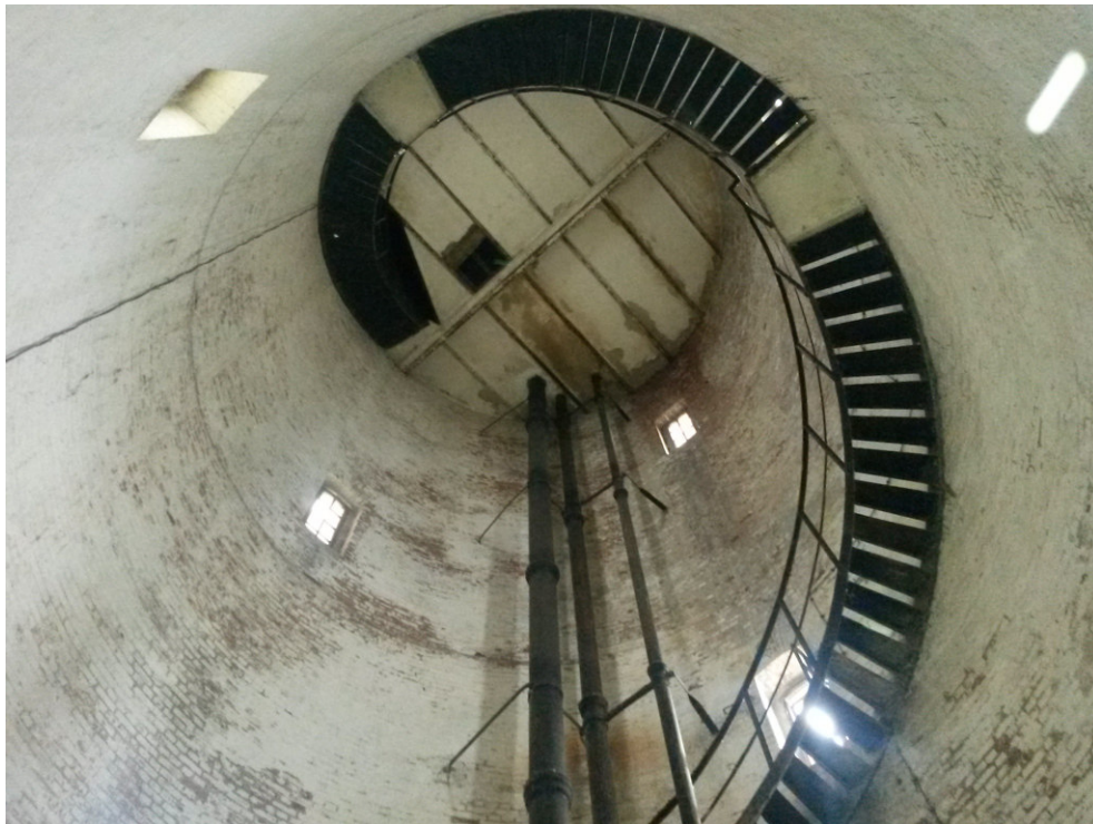
Bild 4 - entgegen gesetzter Blick zur Kuppel unter dem Wasserbehälter
