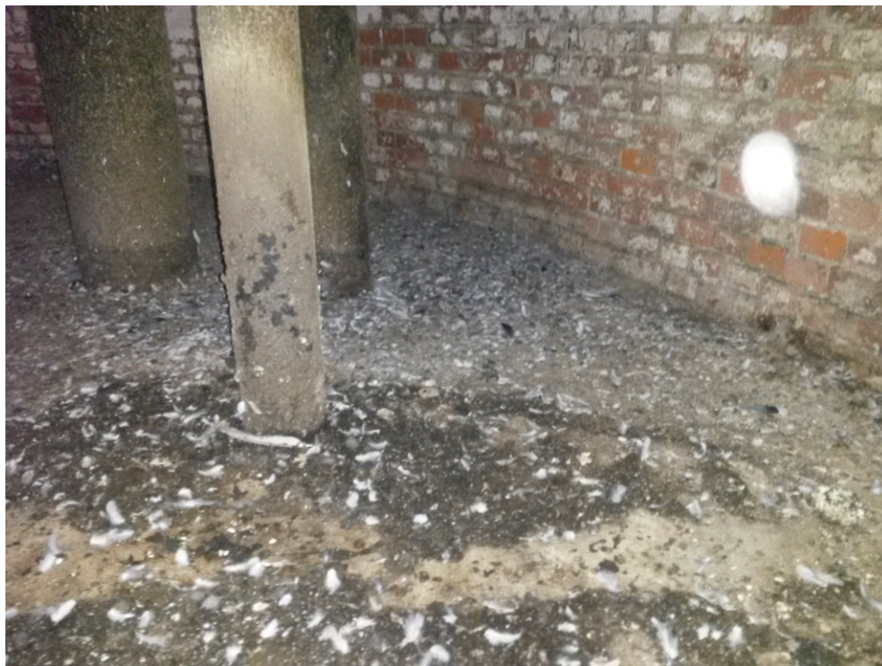
Bild 5 Raum in der Kuppel unter dem Wasserbehälter
