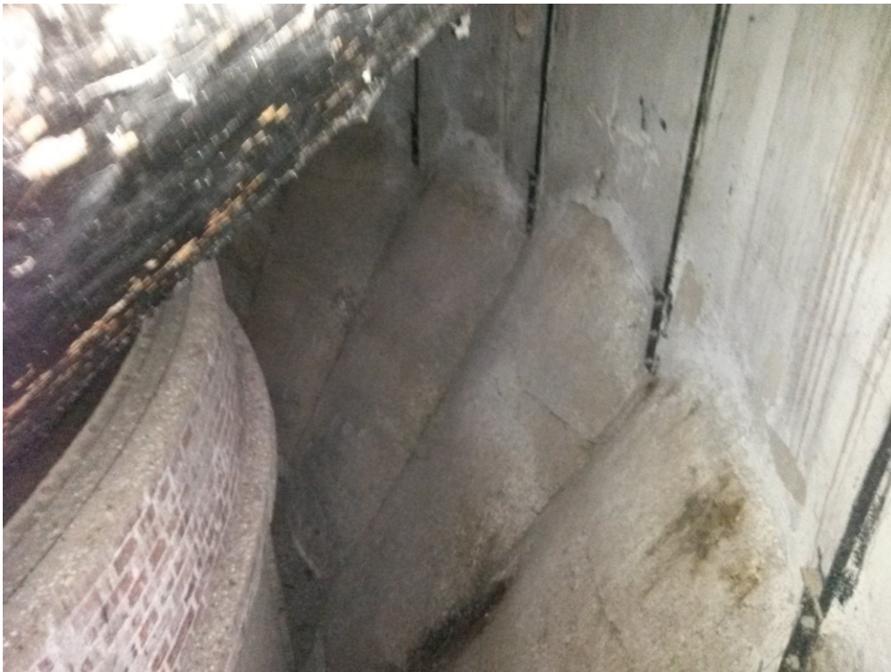
Bild 6 – Kuppel- Außenwand, unteres Ge- schoß
