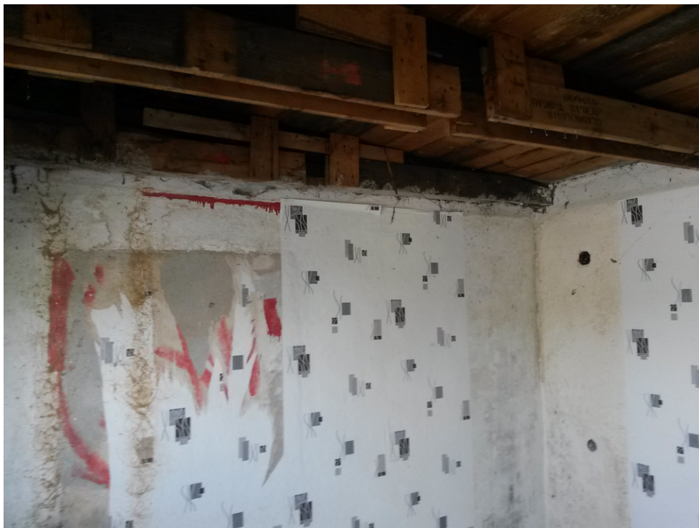
Bild 4 – Kontrolle Innenräume Lauben
