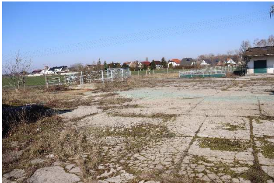
Betonierter Vorplatz mit Verladerampe
