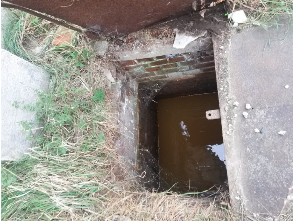
Bild 14 - Gruben in der Freifläche
