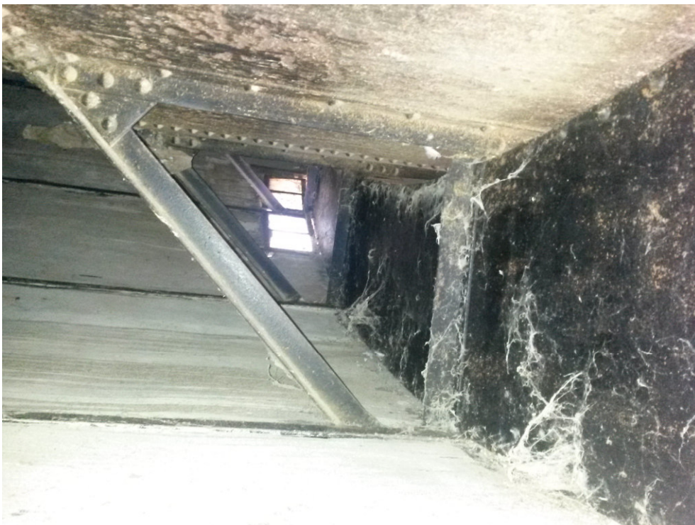
Bild 7 – Raum zwischen Was- serbehälter und Außenwand
